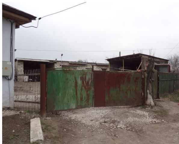
Loc de păstrare și reparație a echipamentului
