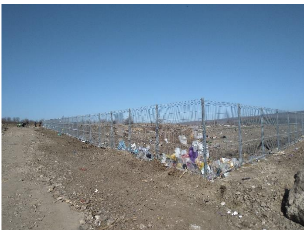
Gard la gunoiștea din Bravicea, r. Călărași
